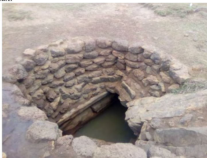
Photo 8: Puits artésien de fortune à Napiébougou
