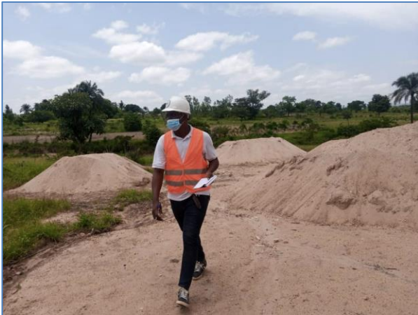
Photo 34: Aperçu du site d'emprunt de sable identifié Source : Consultant, 2022
