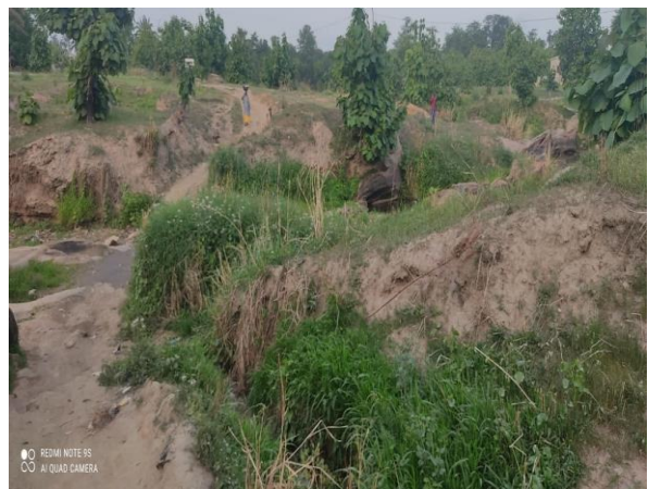
Photo 15: Vue d'ensemble du site du pont Source : Consultant, 2022
