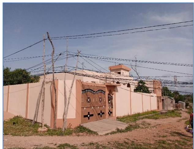
Photo 33: Distribution informelle du courant « système araignées » Source : Consultant, 2022
