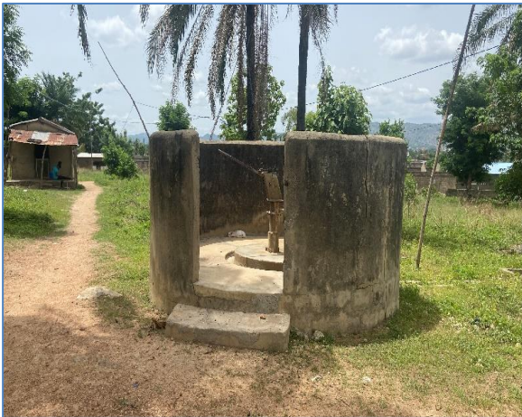
Photo 24: Présence d'une borne fontaine dans l'emprise de la voie d'accès à 50m du site du marché Source : Consultant, 2022
