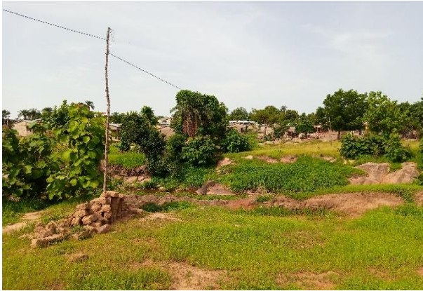
Photo 16: Passage d'un fil de courant traversant la rivière Source : Consultant, 2022
