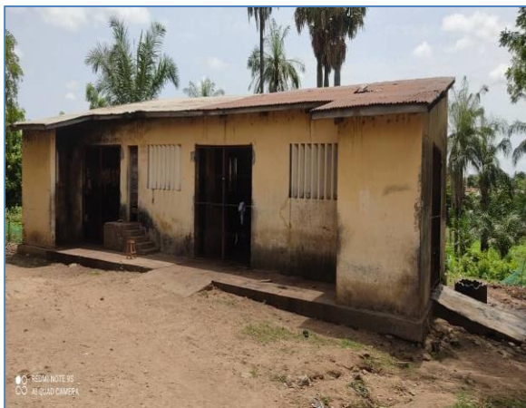
Photo 26: Ancien abattoir dans l'emprise de la voie d'accès Source : Consultant, 2022
